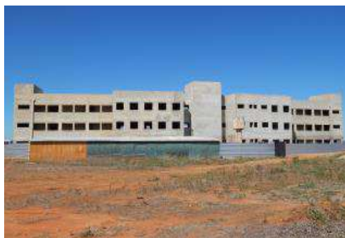
Edifício de Laboratórios de Pesquisa, Campus UFV-Rio Paranaíba.
