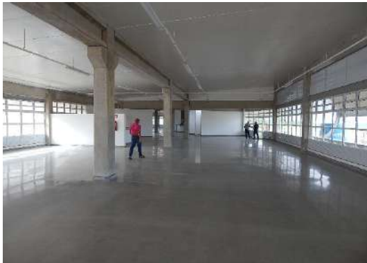
Pisos industriais de alto desempenho utilizados nos Restaurantes Universitários dos três campi da UFV.
