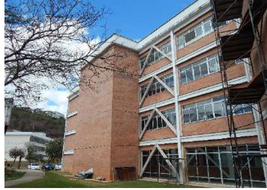
Estrutura em aço do Edifício do CCH-II, Campus UFV-Viçosa .
