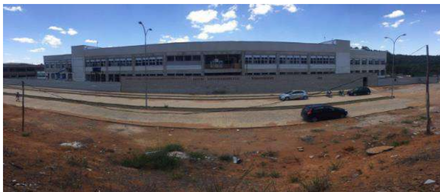
Edifício de Laboratórios de Ensino II, Campus UFV-Florestal.
