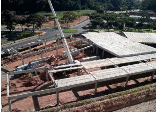
Estrutura em concreto pré-moldado do Restaurante Universitário II, Campus UFV-Viçosa .
