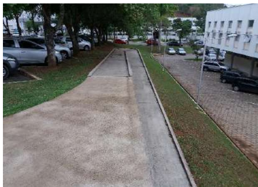
Rampas de acessibilidade, Campus UFV-Viçosa.
