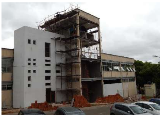
Reforma do edifício da antiga Copeve para novas instalações da Diretoria de Registro Escolar, Campus UFV-Viçosa .
