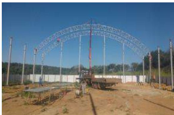
Cobertura metálica para quadra poliesportiva, Campus UFV-Florestal.
