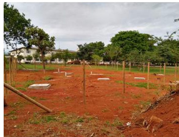
Sistema Fossa-Filtro do CRP-I Fonte: PAD/UFV
