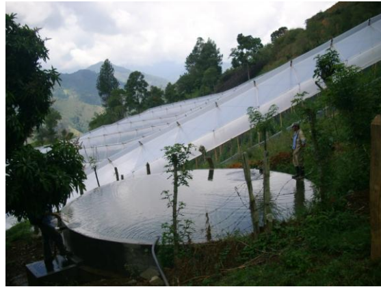
FIGURA 1. Tanque Casquete 50 metros cúbicos, município Salgar - Antioquia – Colombia
