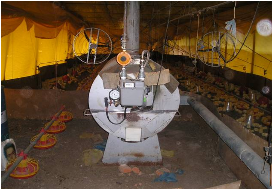
Figura 3A – Fornalha adaptada, tendo como combustível o gás liquefeito de petróleo.
