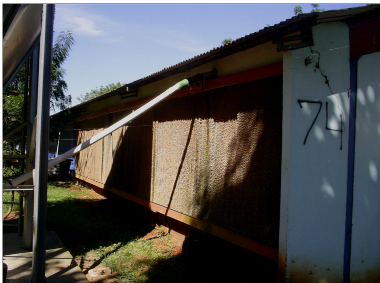
Figura 34. Vista externa do sistema de resfriamento do galpão de aves de corte em Itaberaí, Goiás
