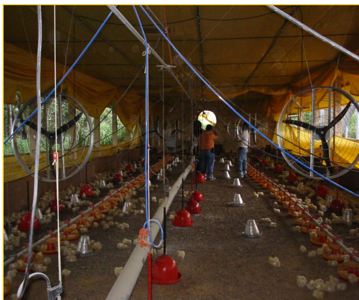
Figura 61. Vista interna do sistema de ventilação do galpão de aves de corte em Barbacena, Minas Gerais
