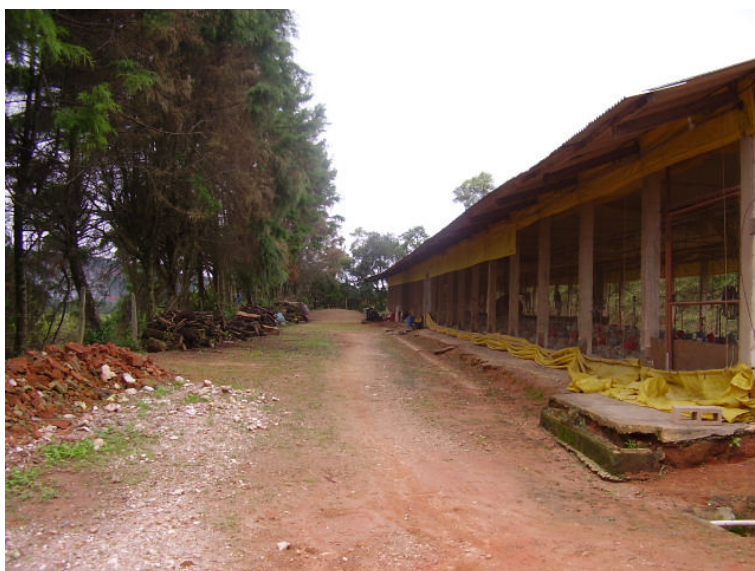
Figura 42. Vista externa da cobertura e do entorno dos galpões de frangos de corte em Barbacena, Minas Gerais
