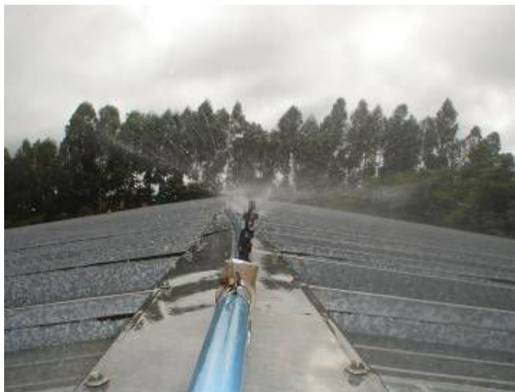
Figura 24. Vista superior do sistema de aspersão sobre a cobertura dos galpões de aves de corte em Rio Verde, Goiás
