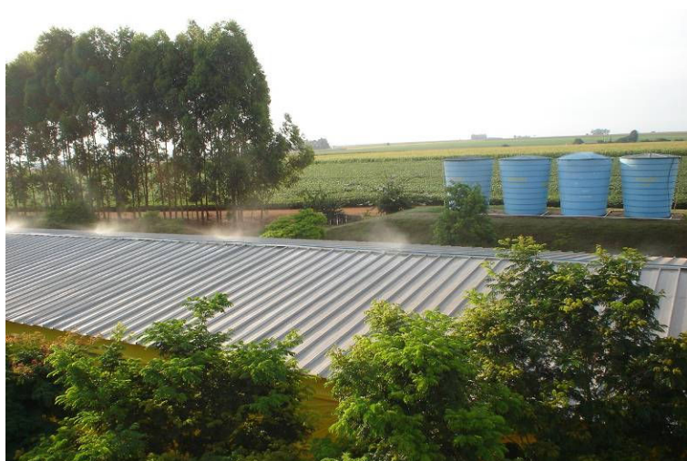
Figura 23. Vista do sistema de aspersão sobre a cobertura dos galpões de aves de corte em Rio Verde, Goiás
