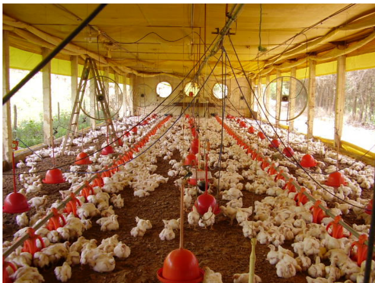
Figura 45. Vista interna do sistema de ventilação do galpão de frangos de corte em Barbacena, Minas Gerais
