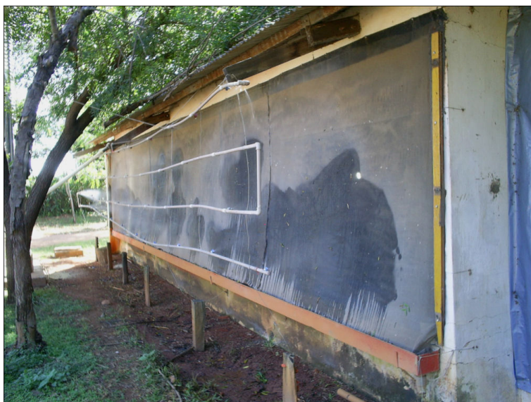
Figura 35. Vista externa do sistema de resfriamento com placas umedecidas cobertas com sombrite do galpão de aves de corte em Itaberaí, Goiás
