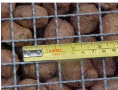
Figura 2 – Vista frontal do painel de Argila expandida.
