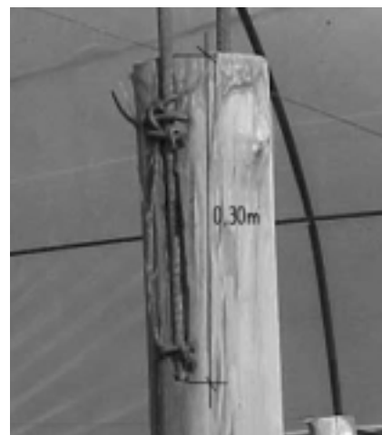
Figura 7 - Detalhe do encaixe e fixação da estrutura metálica na cavidade feita no pilar central.
