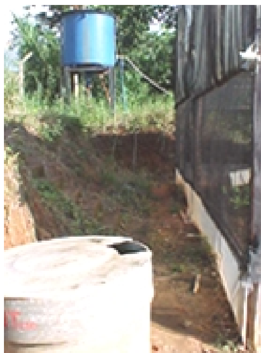
Figura 21 - Proximidade do tratamento S do talude.
