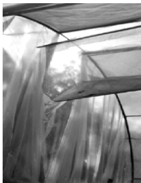
Figura 12 - Fechamento da abertura frontal da cobertura com lanternim.
